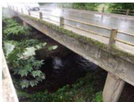
Foto 2.4 - Rio Catu sob travessia da Rod. BA-093
