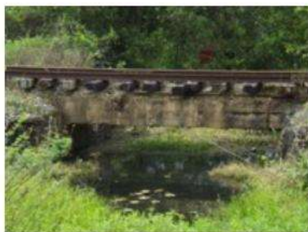
Foto 2.3 - Rio Catu sob obra de arte férrea
